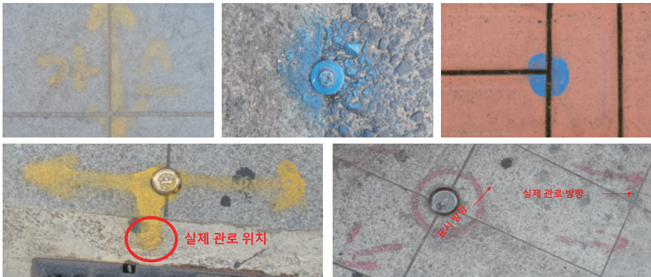
<인식 표지 유실 및 미설치로 관로(페인트) 표시 사례>
