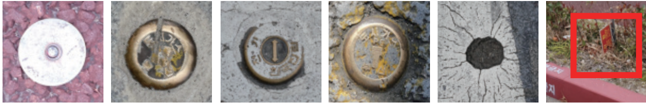
<현행 관로 인식표지 파손 및 유실 사례>
