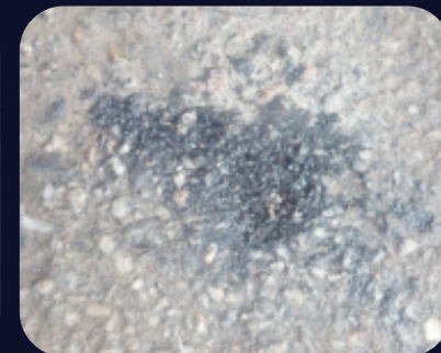
시공 후 노면 모습
